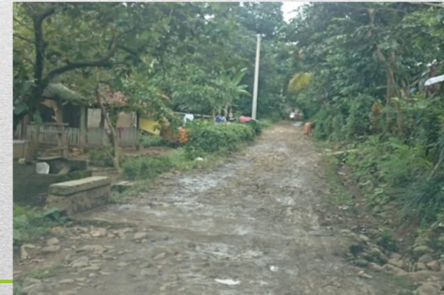
Kondisi mayoritas Jalan Desa Pabuaran
